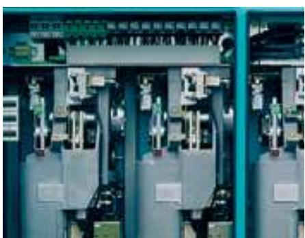
Пример: обычная система управления силового выключателя
