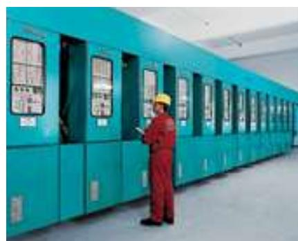
Ячейка с интегрированным шкафом местного управления
