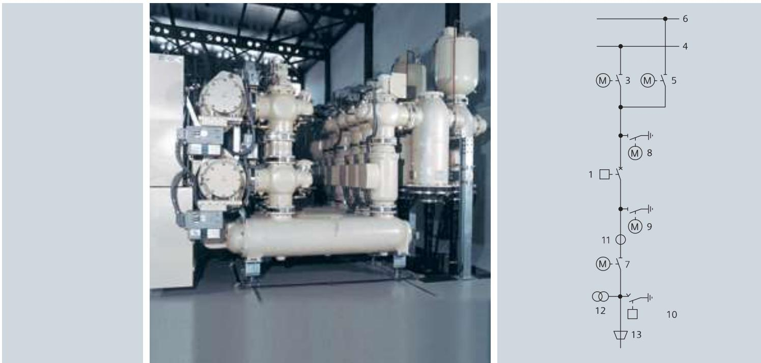
Небольшим количеством модулей возможна реализация всех возможных электрических схем распределительств
